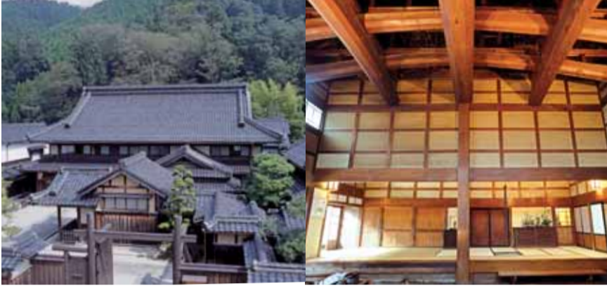
築300年の鳥取の家。珍しい樫が使われており、瓦は地元産です。地産地消の精神を元に建てられ、文化財として立派に現役を務めています。
