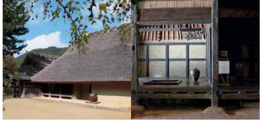
築1200年以上といわれている、兵庫県の家です。日本で最も古い家で、柱は杉の5寸角です。母屋、離れ、築山、中庭、納屋、土蔵等で構成されています。
